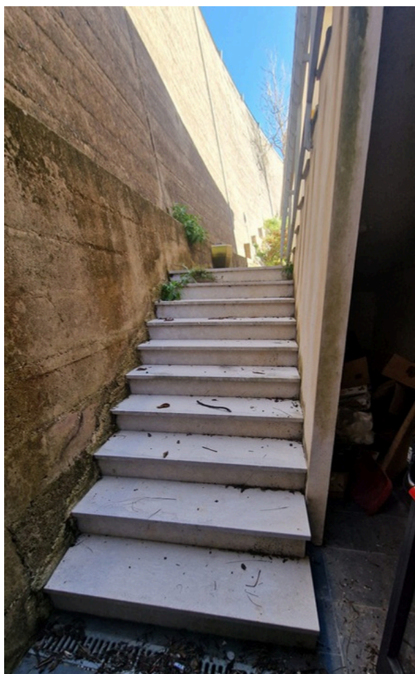
SCALINATA ESTERNA ALL'USCITA DI EMERGENZA DEL TEATRO
